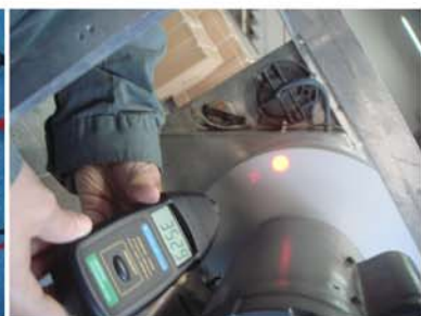
Rotação de ventiladores
