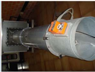
Vazão em VAV
